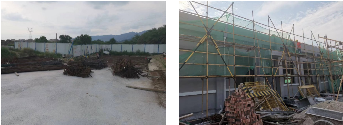
图4-3 项目施工扬尘采取防治措施照片
