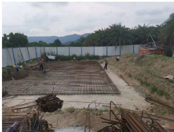
图4-5 噪声防治措施（施工场地围挡作业）
