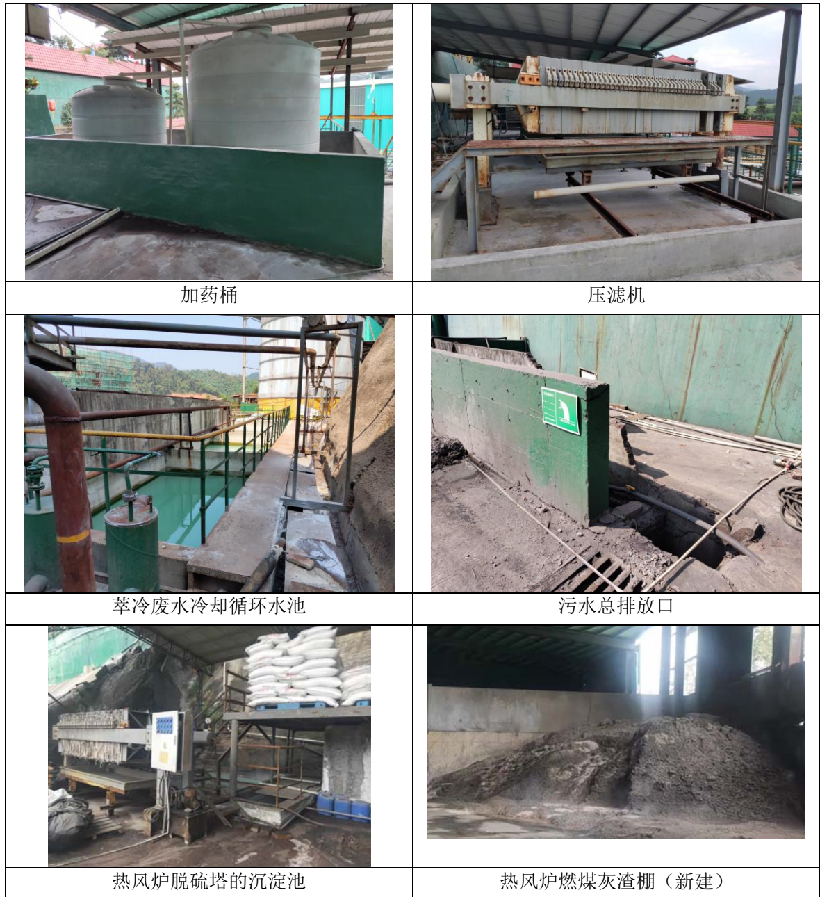
图 4.1-2 本项目污水处理设施现状图
