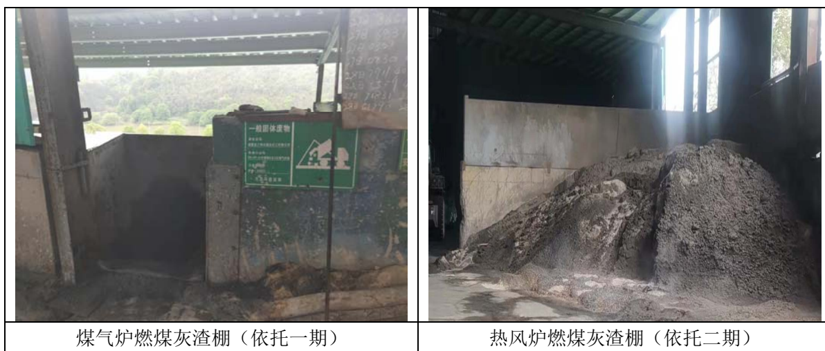
图 4.1-4 固废暂存设施现状图
