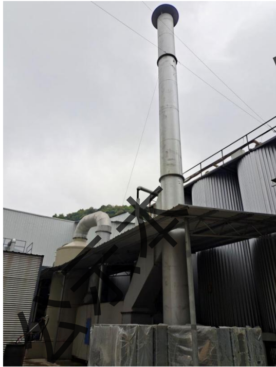
沥青烟废气处理设施 (碱洗喷淋塔+活性炭吸附+15 m 高排气筒)
