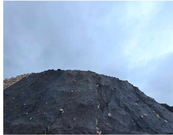
堆场防尘网覆盖
