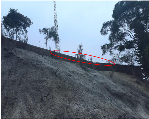
厂界喷淋设施
