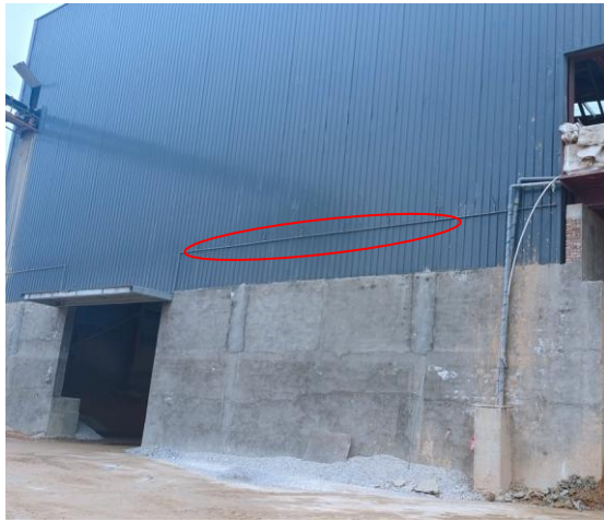
车间喷淋设施
