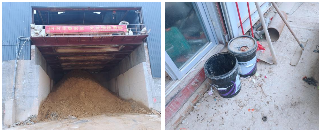
沉淀污泥暂存处
