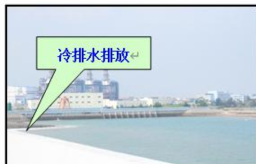
项目冷排水排放口
