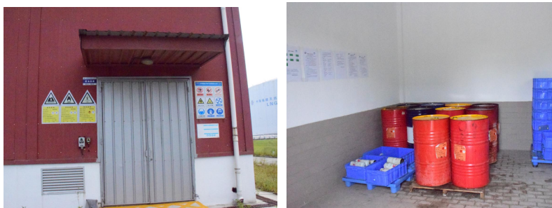
图 2.3-1 企业现有危废暂存库
