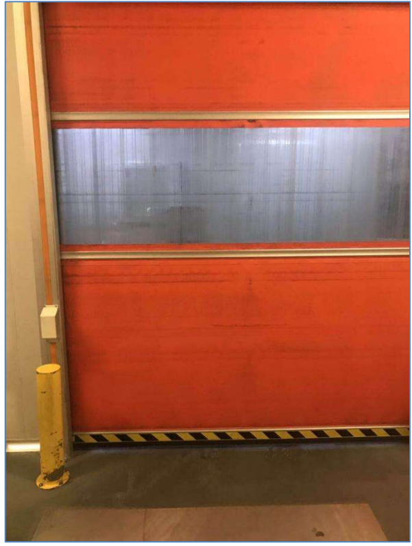
厂区安全隔断门
