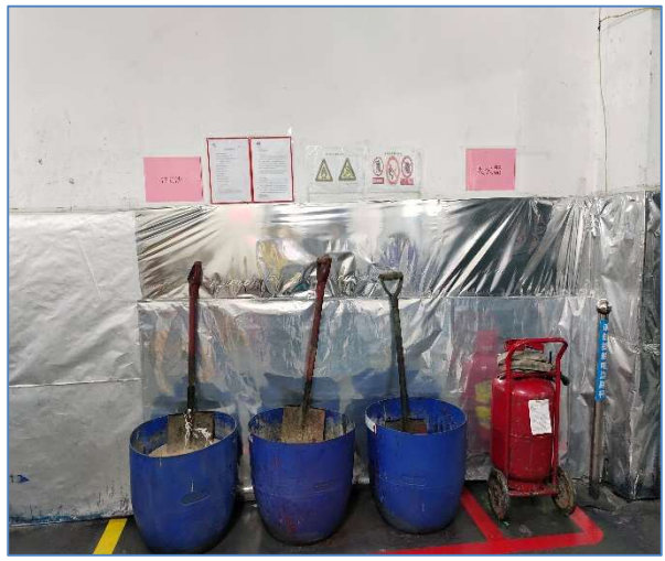
消防沙、灭火器
