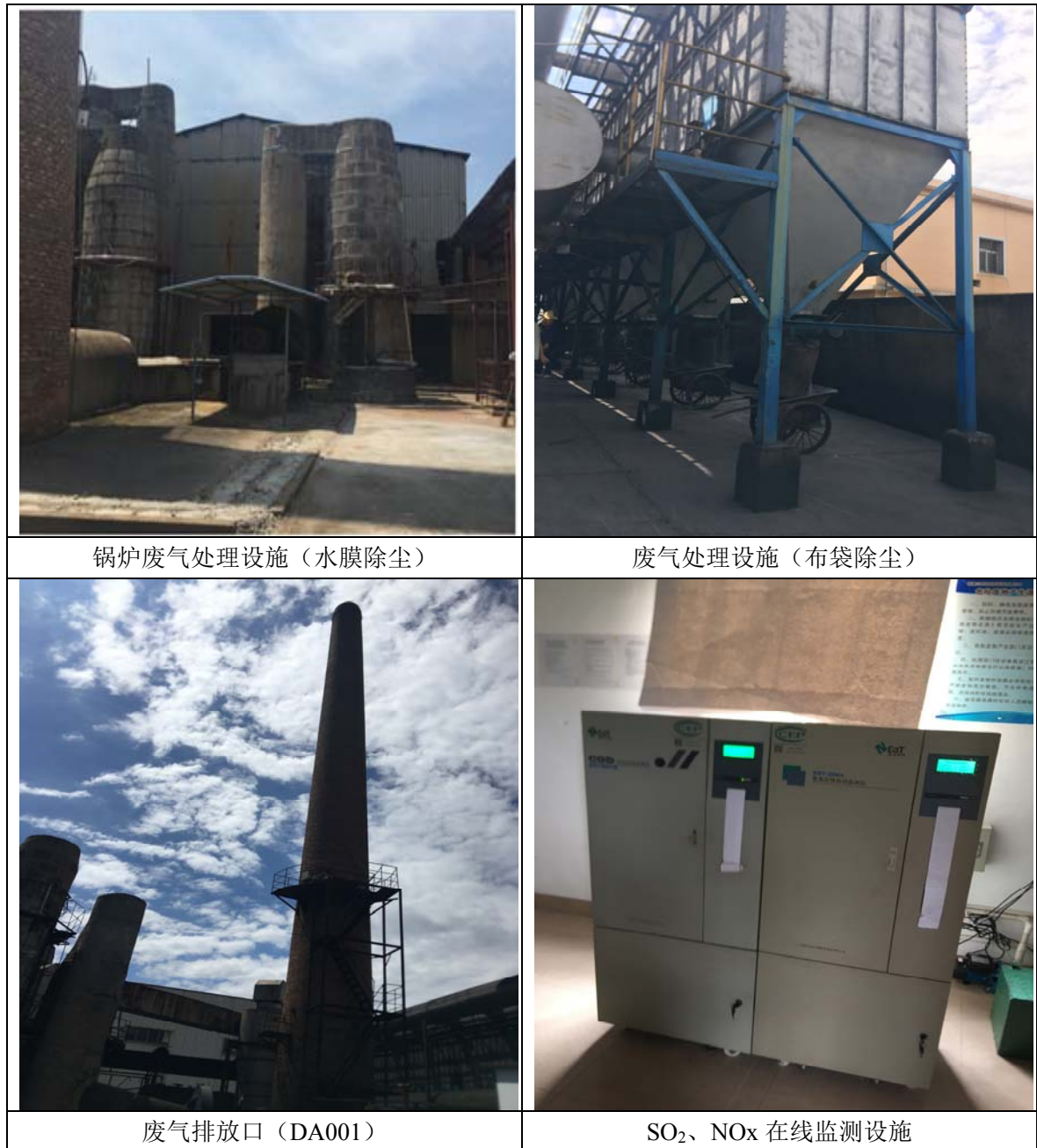
图 4.2-1 废气处理设施图
