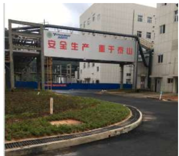
厂区已建厂房
