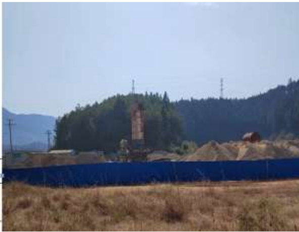
厂区东侧园区公用工程施工场地
