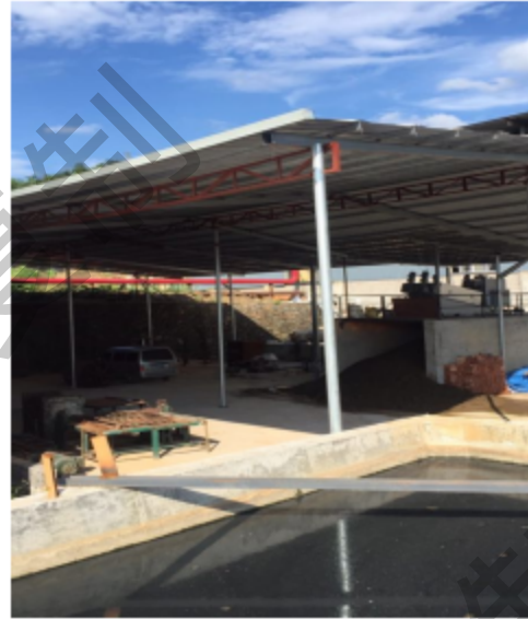
污水处理设施及物料堆场
