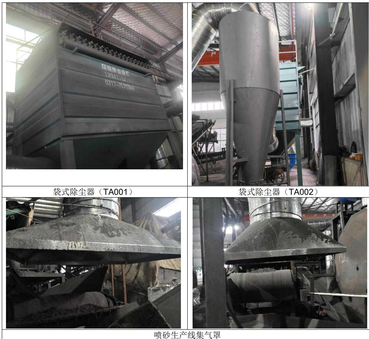
图4.1-2 验收阶段 废气治理设施照片
