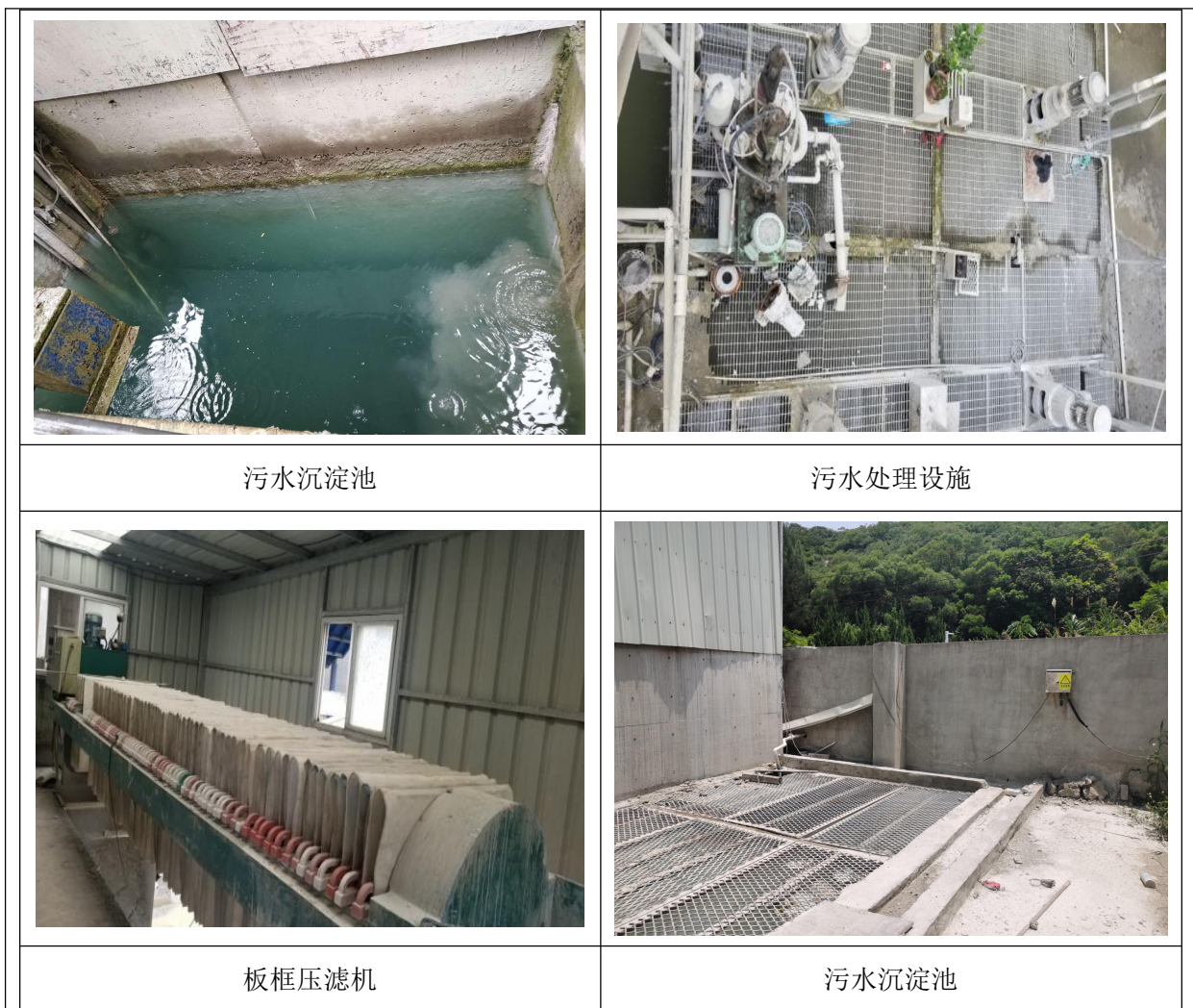
图 3-1 生产废水环保设施照片
