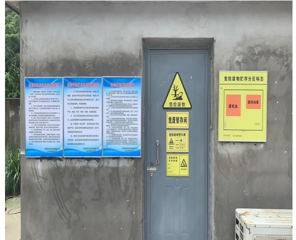
危废暂存间（外部）
