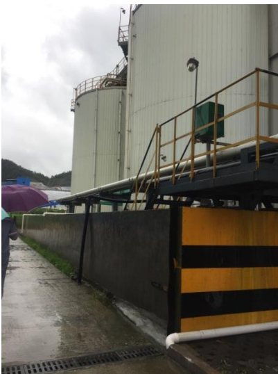
PPA 装置磷酸罐区围堰、防腐
