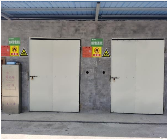
危废暂存间（暂存废活性炭）
