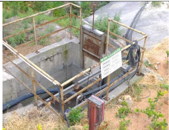
磷石膏临时堆场初期雨水收集池
