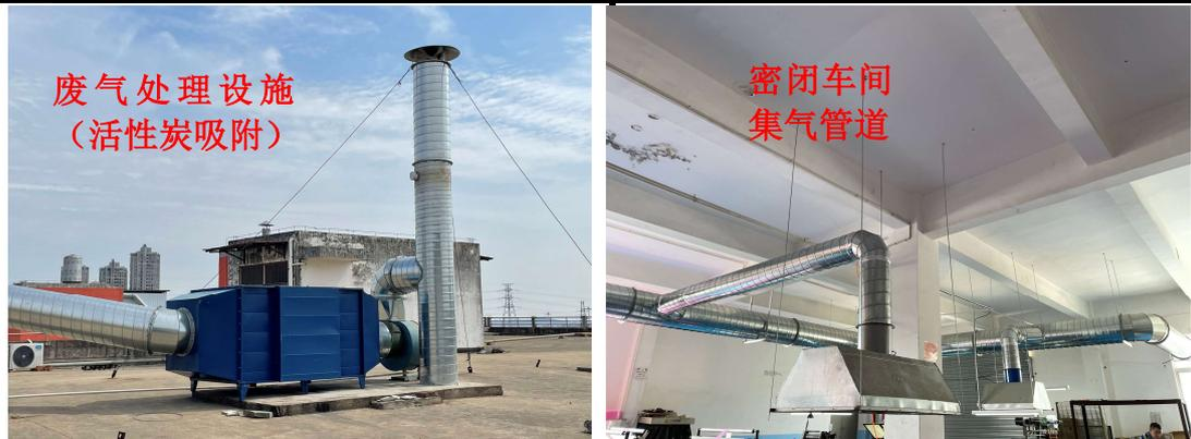
图 3-1 废气污染防治措施照片
