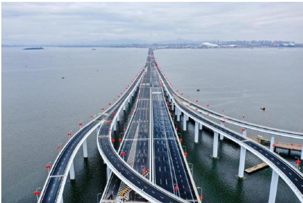
图 2.1-1 跨海大桥钢箱梁（连续梁）
