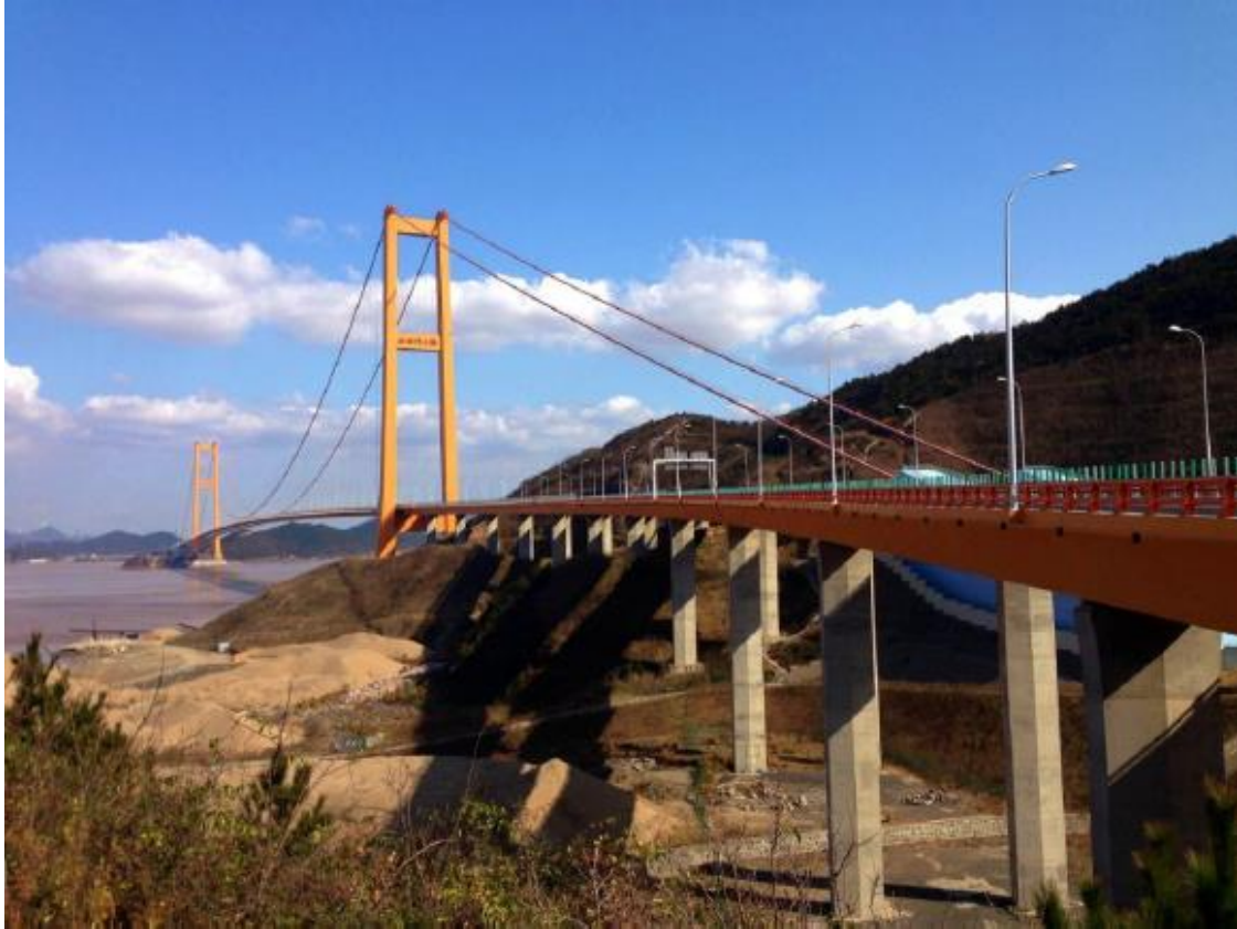
图 2.1-2 跨海大桥钢箱梁（通航孔悬索桥）
