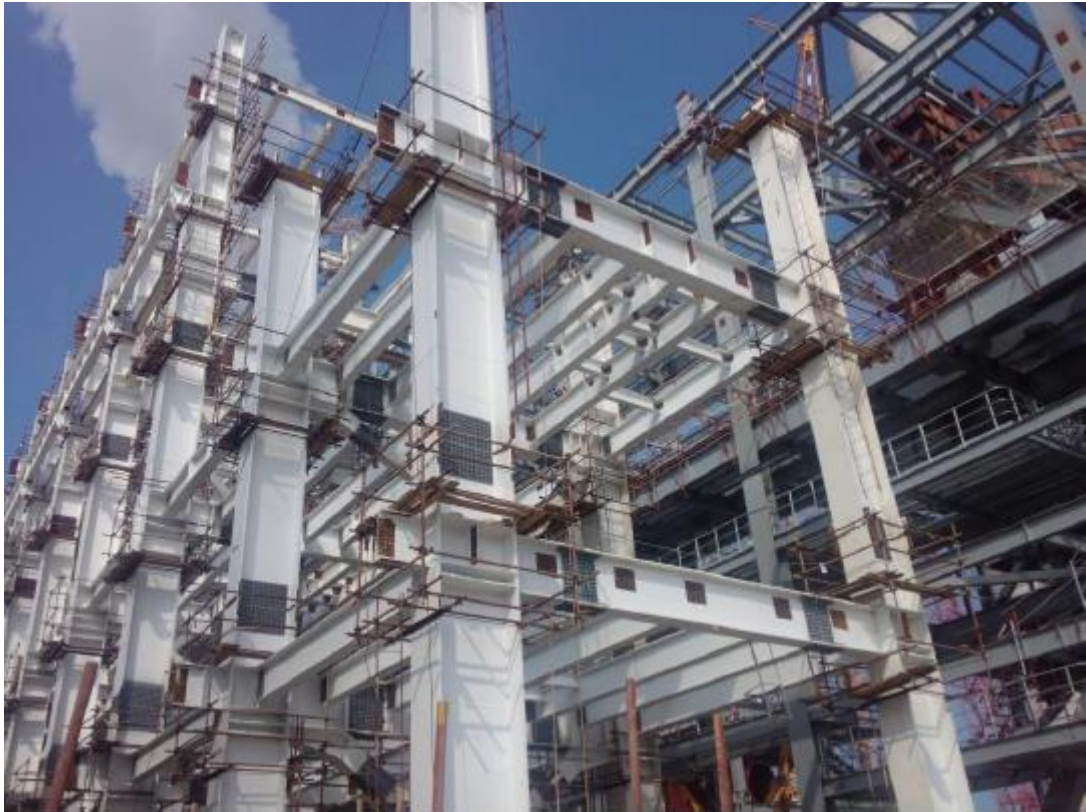
图 2.1-6 重型厂房钢结构（鸿山电厂）
