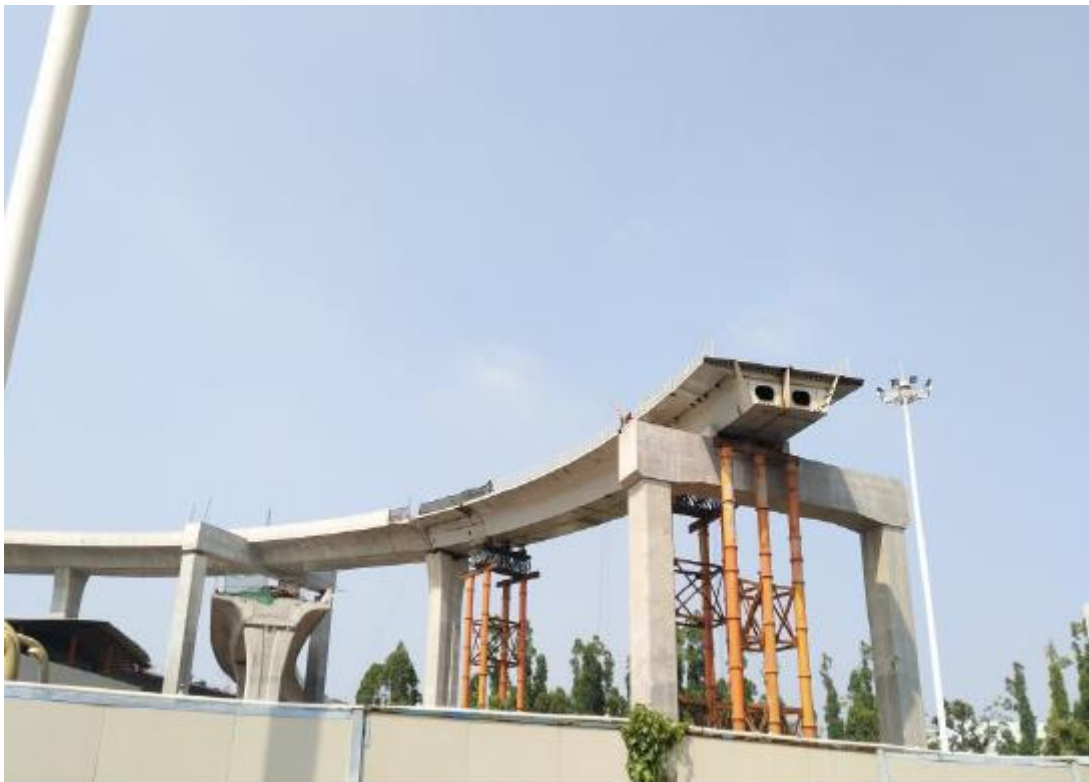
图 2.1-3 市政跨线桥钢箱梁（海沧隧道接线）
