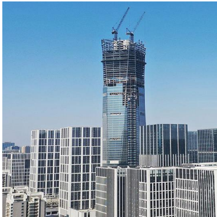
图 2.1-5 高层房建重型钢结构
