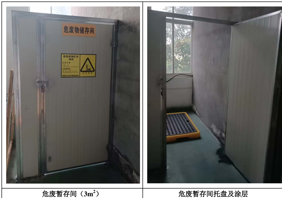
图 4.1-3 固体废物暂存设施照片
