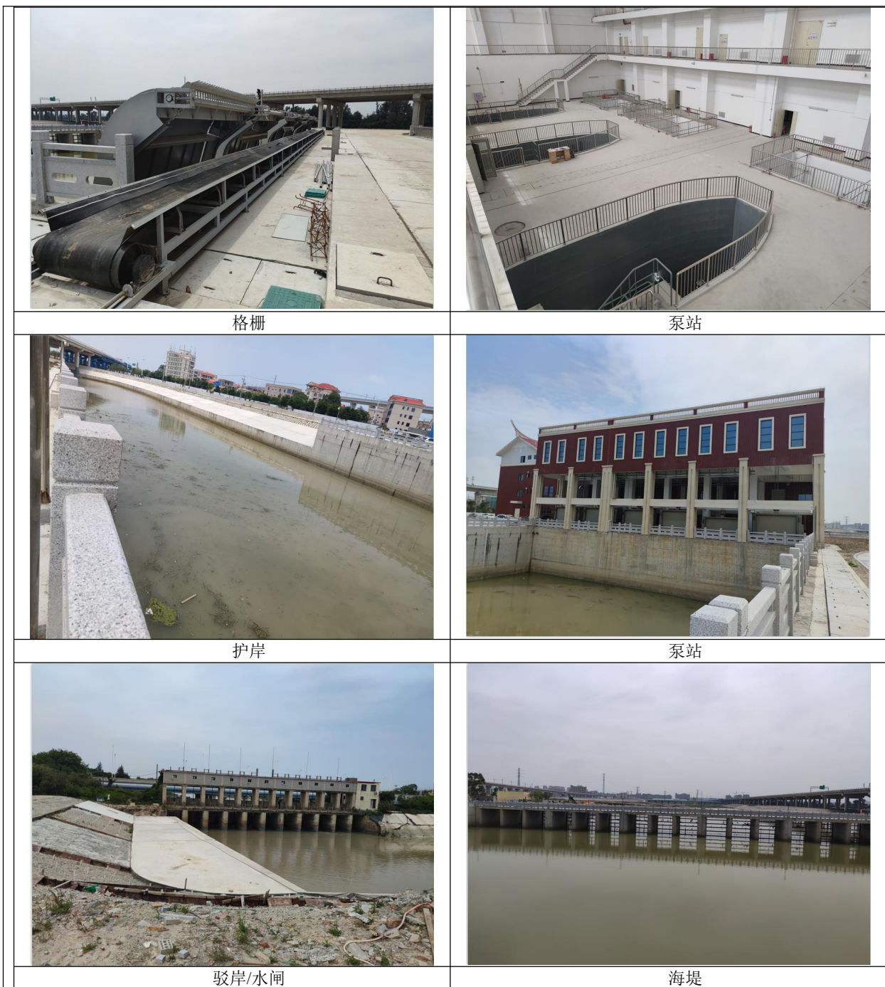
图 4-1 项目现场照片
