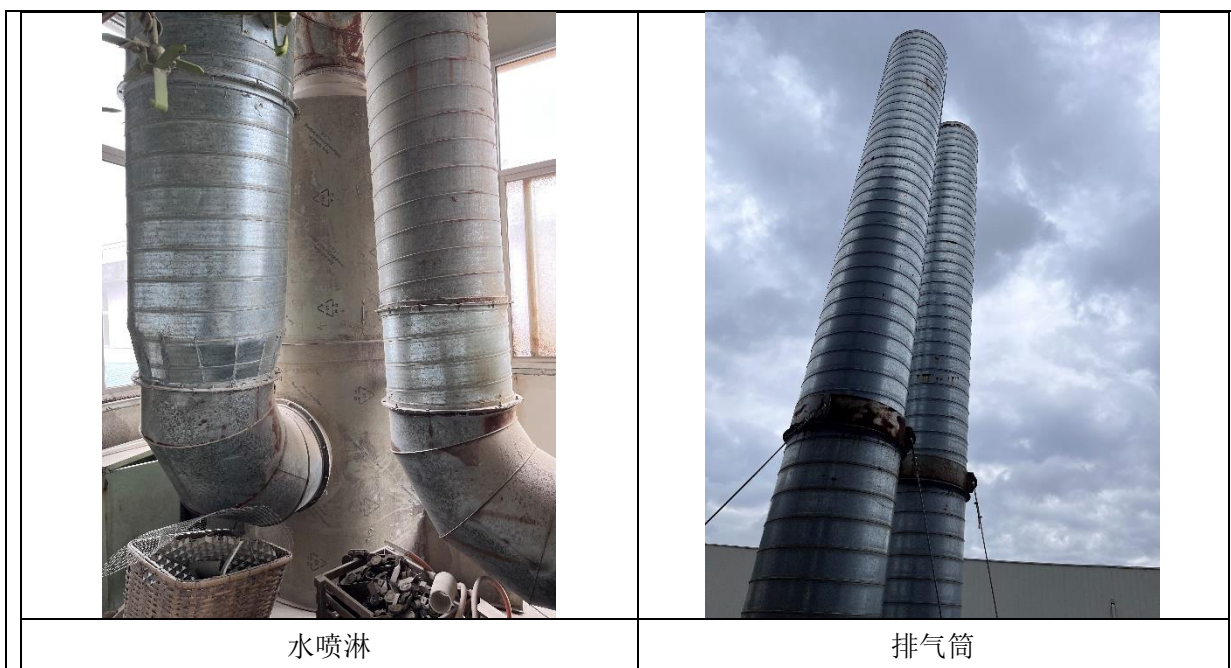
图 3-4 项目废气治理设施照片
