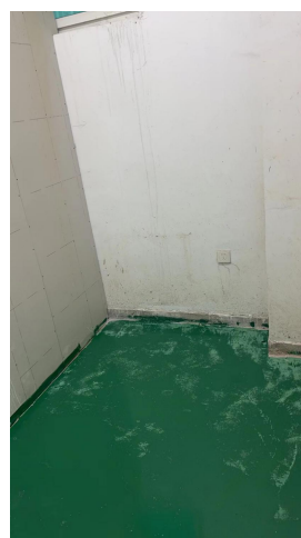
危废暂存间内部
