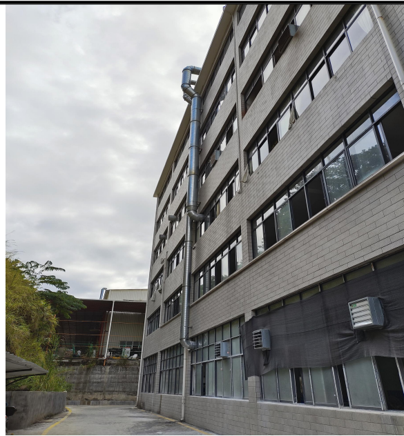
废气管道 (DA001)
