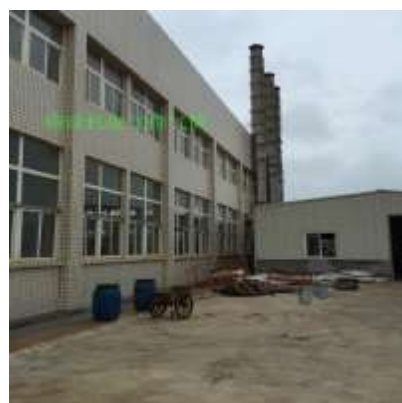
喷涂废气排气筒
