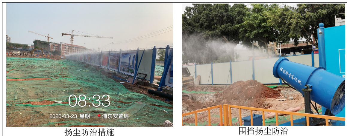
图 4-3 施工期扬尘治理措施局部图
