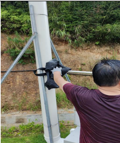
污水站臭气排气筒
