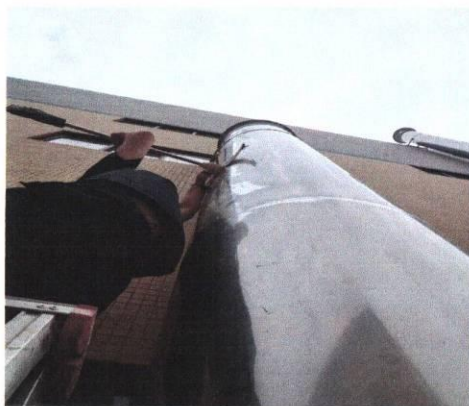
挤出及压延车间废气处理设施进口（Q1 进口）
