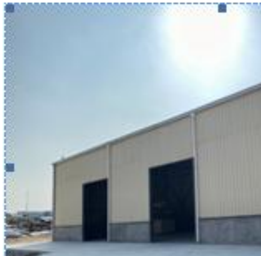
一般固废暂存间
