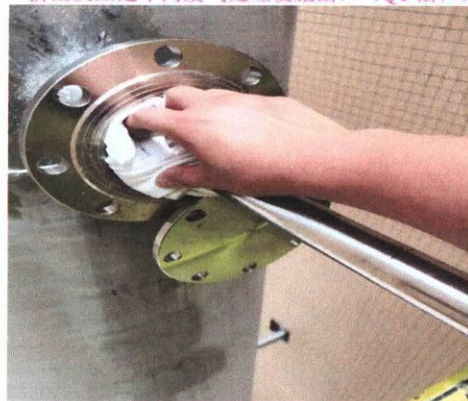
硫化车间废气处理设施出口（Q2 出口）
