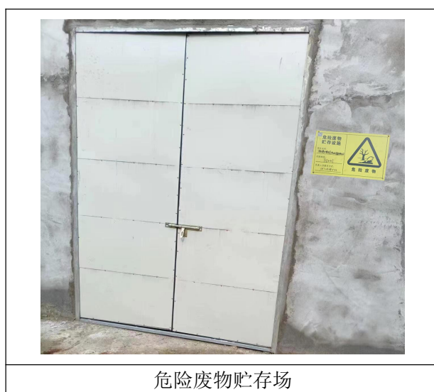
图4-3 危废废物贮存场现场照片
