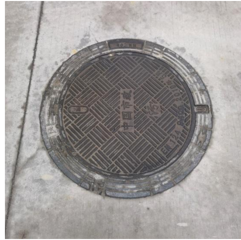
生活污水排放口
