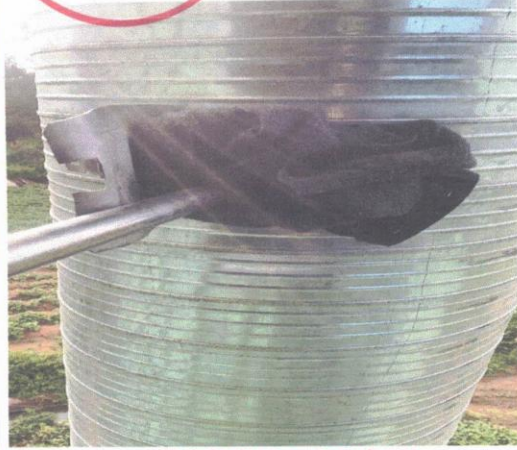
工艺废气出口 2 (Q2 出口)
