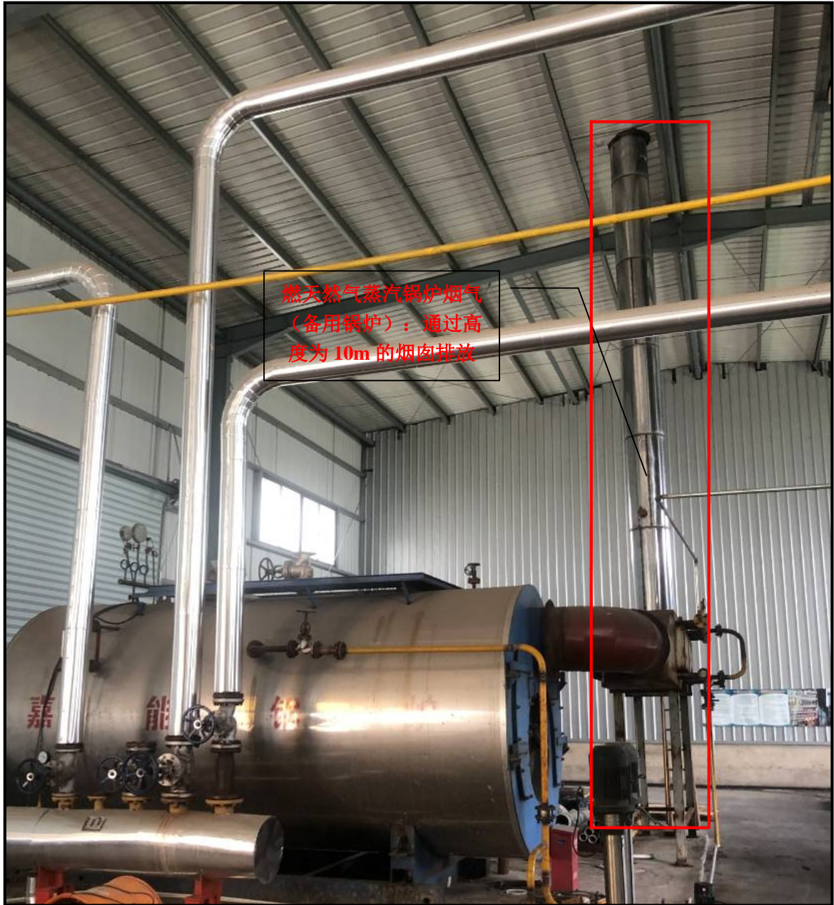
图 4.1-3 项目废气治理设施现场拍摄图 (1)
