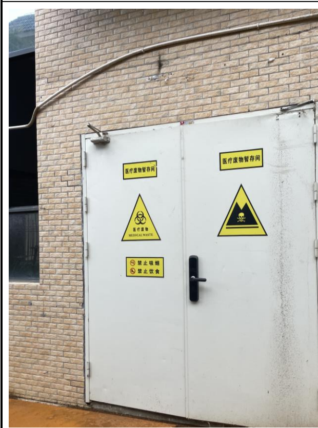
危险废物暂存间
