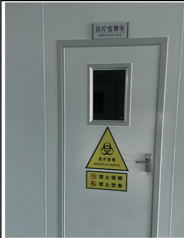
3F 医疗废物暂存间
