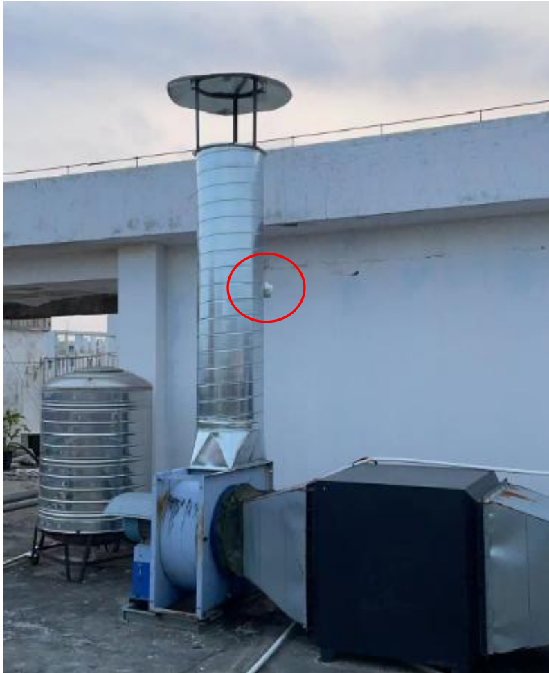
图片 3 油烟废气监测孔
