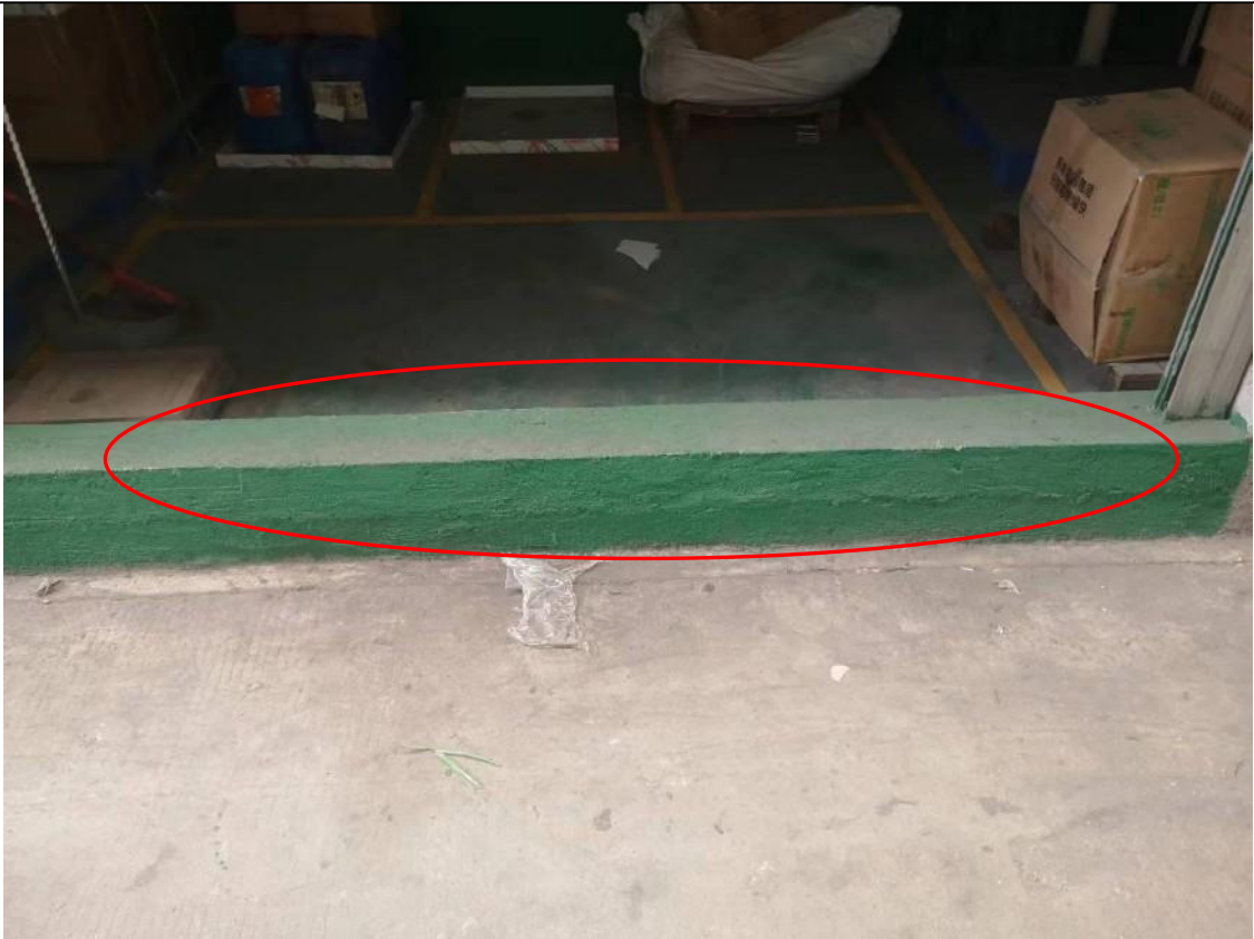
图片 1 危险废物暂存间围堰设施
