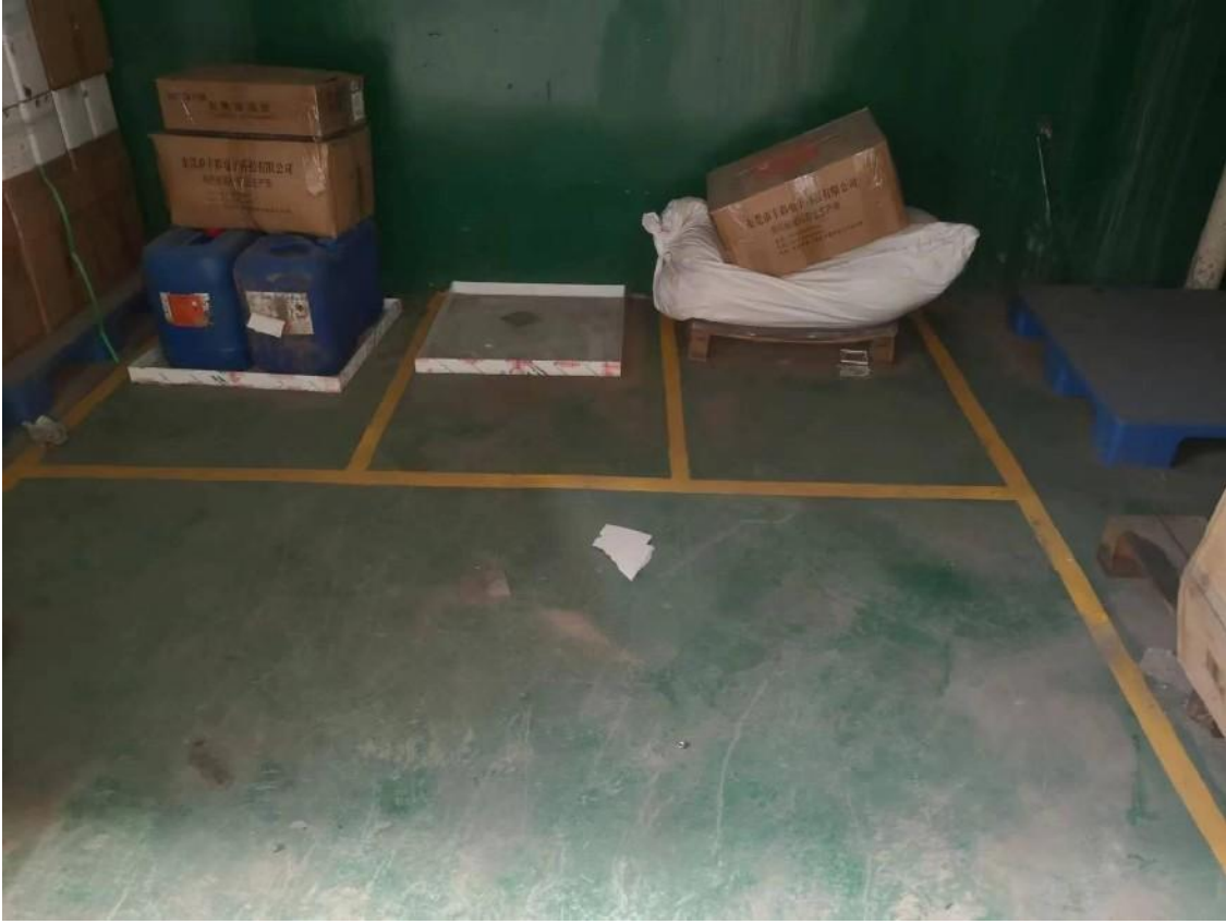
图片 1 危险废物暂存间内防渗设施
