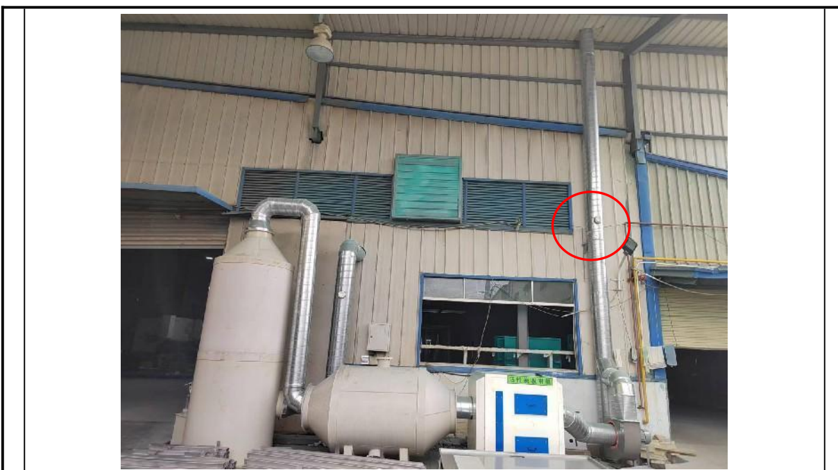
图片 1 喷塑后烘干及燃料废气监测孔
