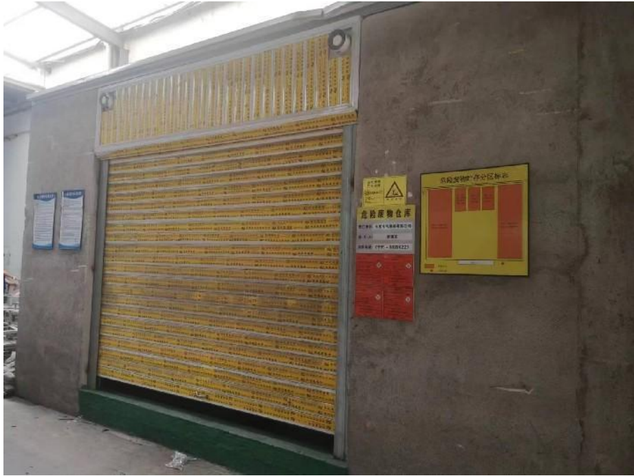
图片 1 危险废物暂存间
