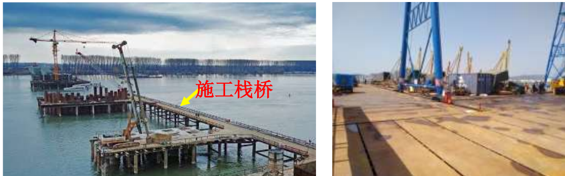
图 2.4-6 典型跨海桥梁临时施工栈桥示意图
