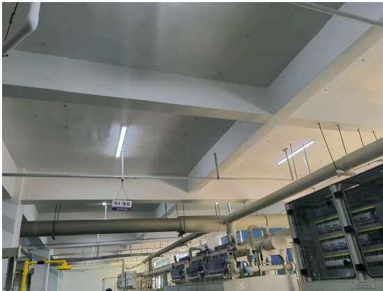
蚀刻、化学清洗工序集气设施
