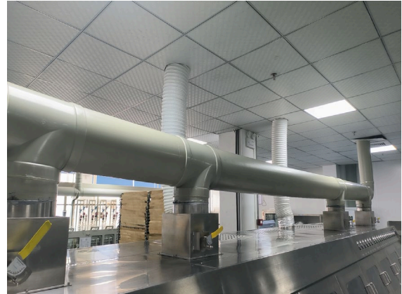
蚀刻、化学清洗工序集气设施
