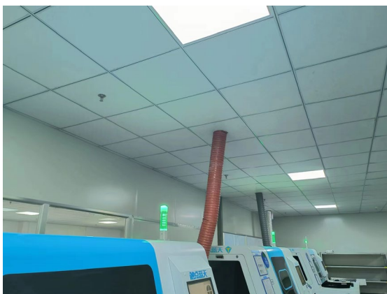
激光切割、钻孔工序集气设施
