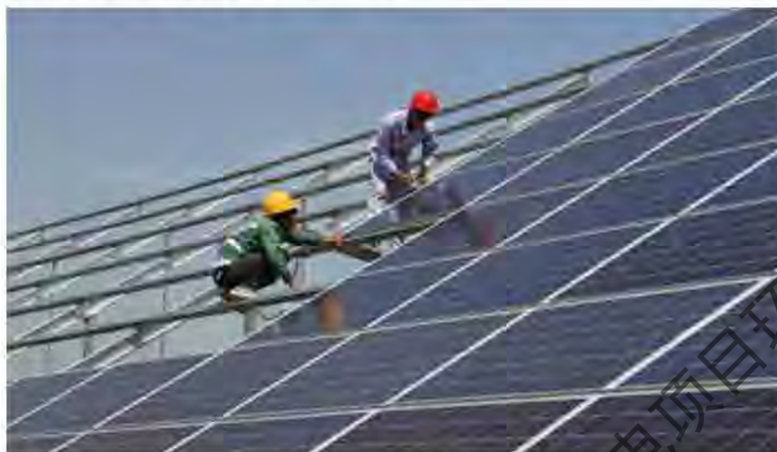
图 2.4-6 光伏板安装施工图
