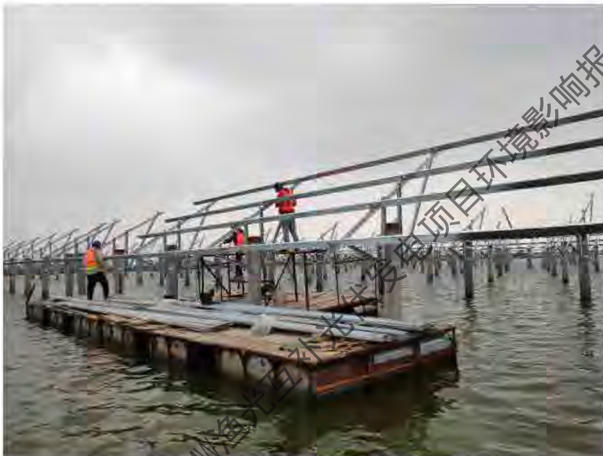
图 2.4-5 光伏组件安装示意图
