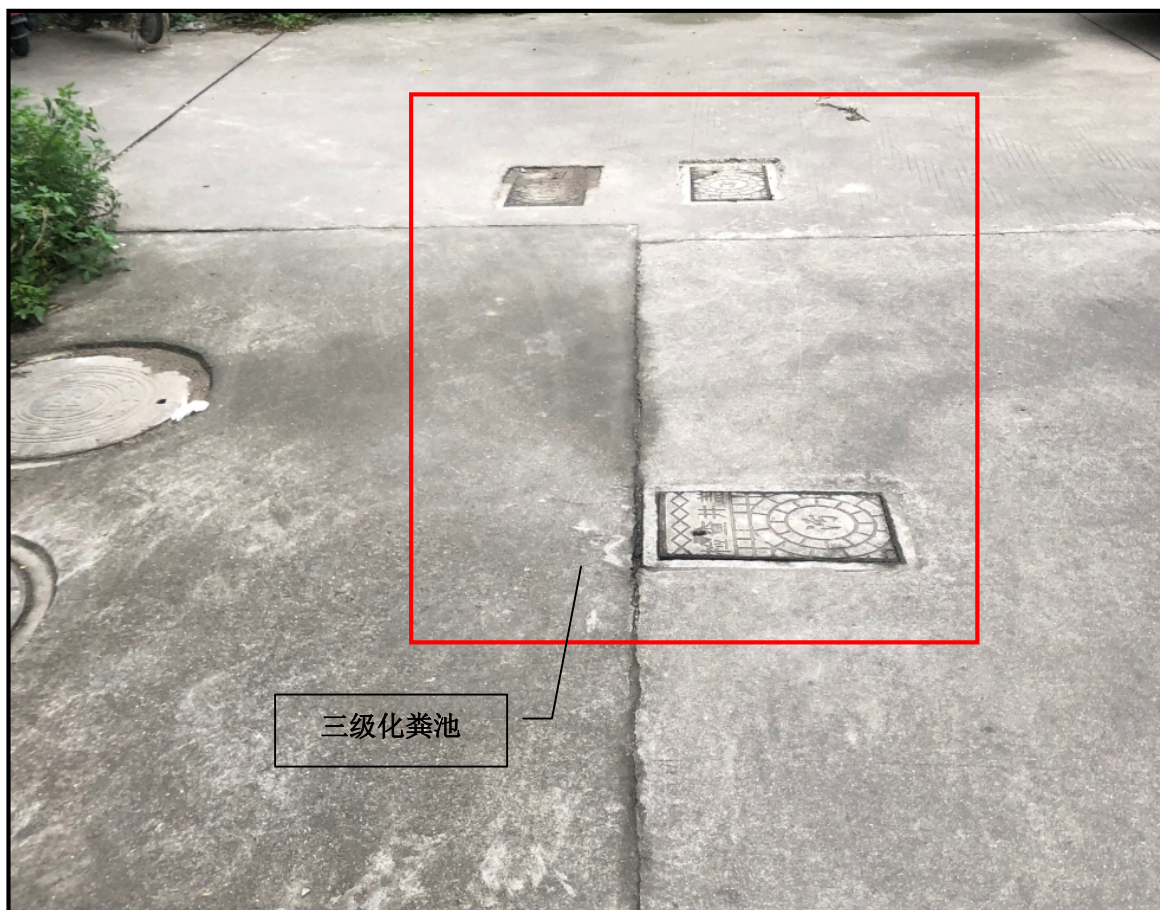
图 4.1-2 项目废水治理设施现场拍摄图
