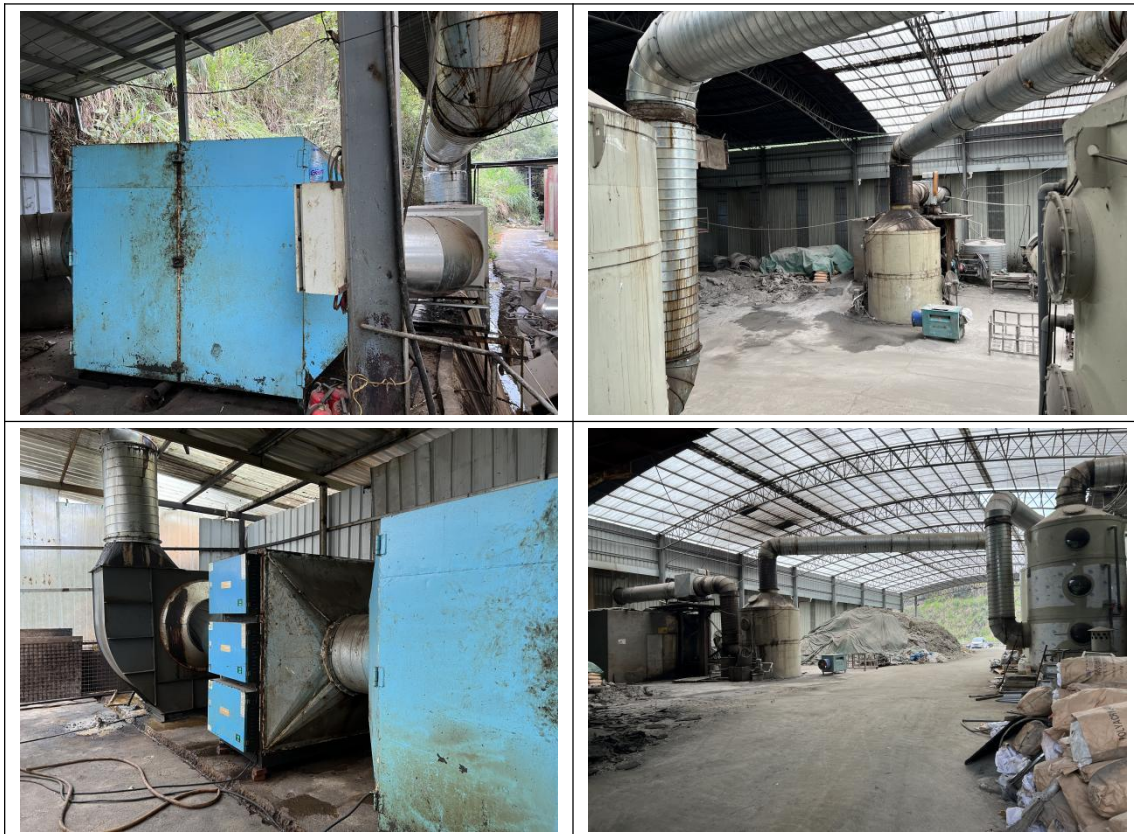
图 4.1-5 废气处理设施图
