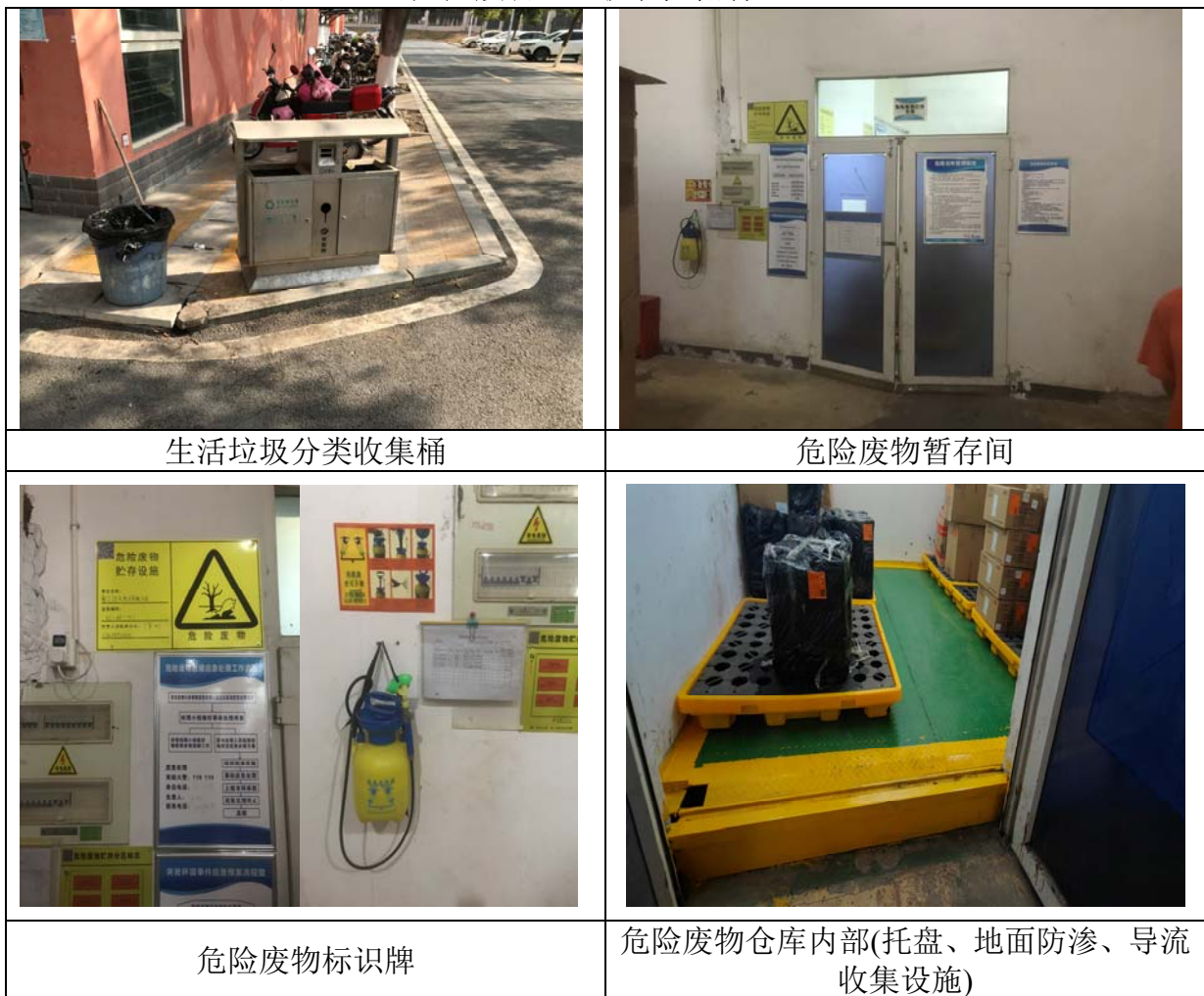
图4.3 固废处理设施现场调查照片
