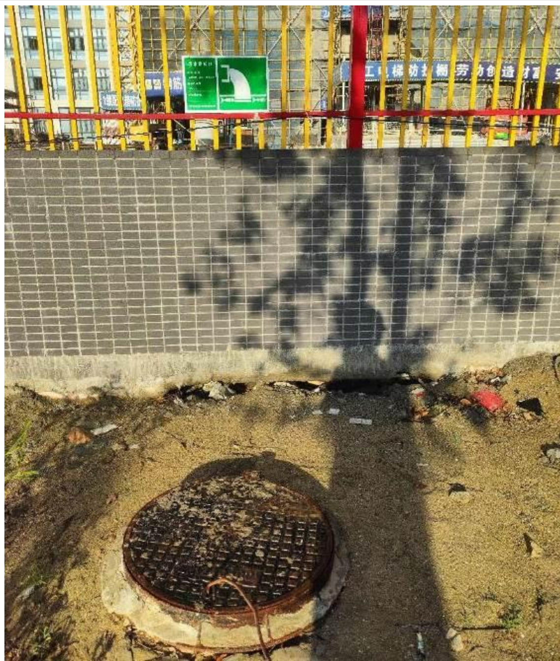
图 3.2-1 化粪池处理后污水排放口现状图
