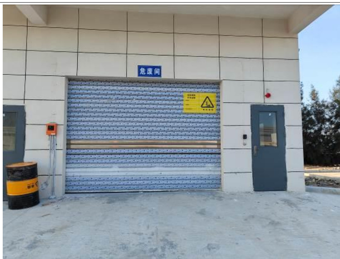
危险废物贮存场所
