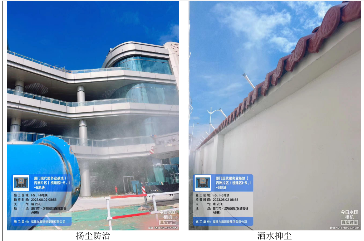
图 4-3 施工期扬尘治理措施局部图
