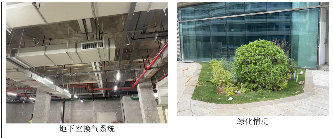
图 4-4 废气设施设置情况现场图
