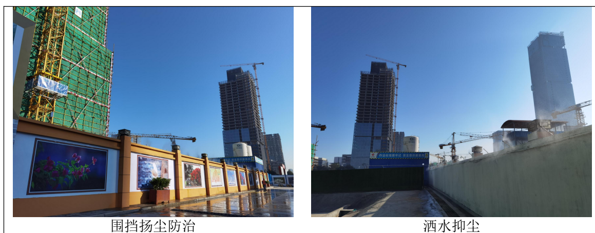
图 4-3 施工期扬尘治理措施局部图
