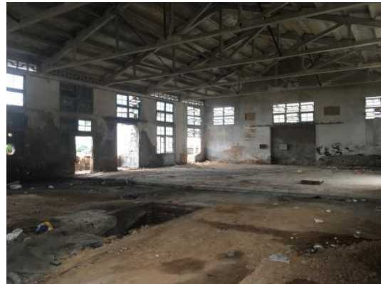
扩建项目现有厂房内部（一期工程现状）
