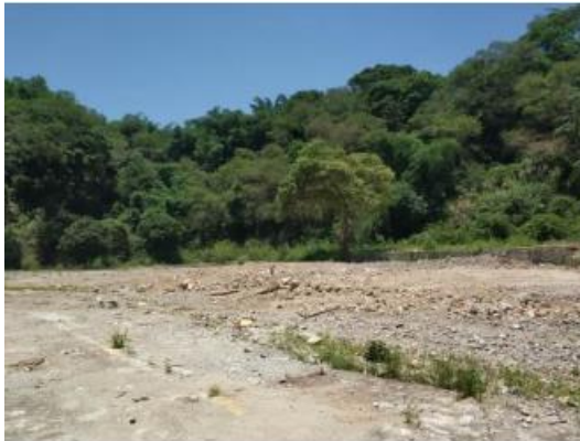
扩建项目局部块（二期工程现状）
