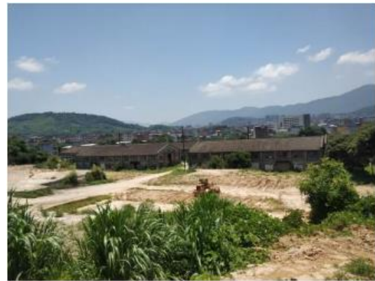
扩建项目局部地块（一期工程现状）
