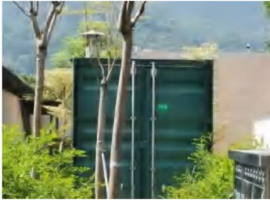
污水处理设施
