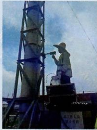
Z15 工业污水站除臭塔废气排口（◎12）
