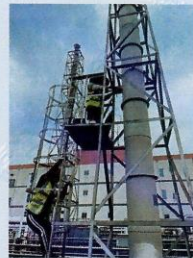
Z2 食堂污水站废气处理设施出口（◎13）
