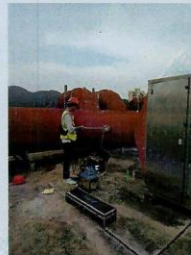
Z5 厂房喷涂废气 3 处理设施进口 2 (◎10)
