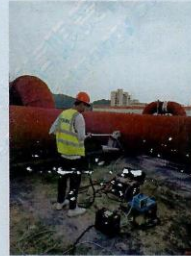
Z5 厂房喷涂废气 2 处理设施进口 2 (◎7)
