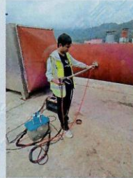
Z5 厂房喷涂废气 1 处理设施进口 1 (◎3)
