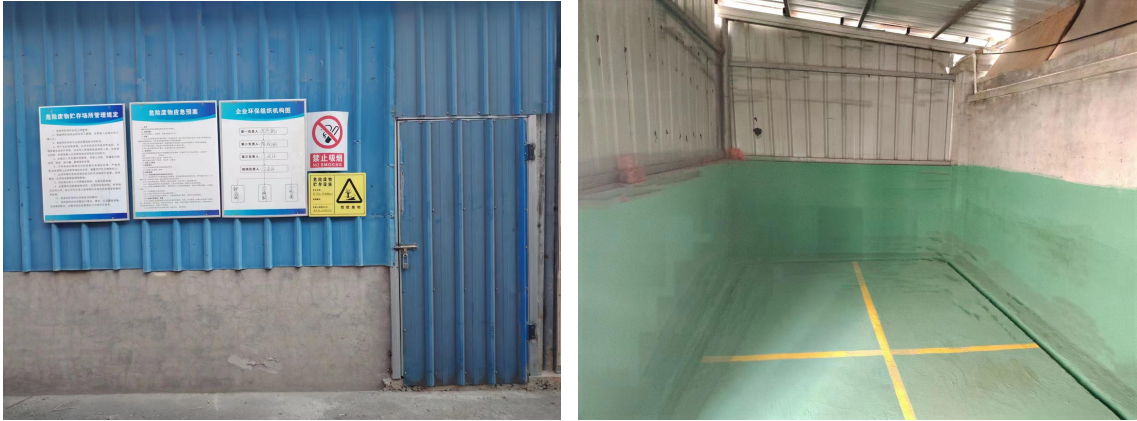
图 4-3 危险废物暂存场所图
