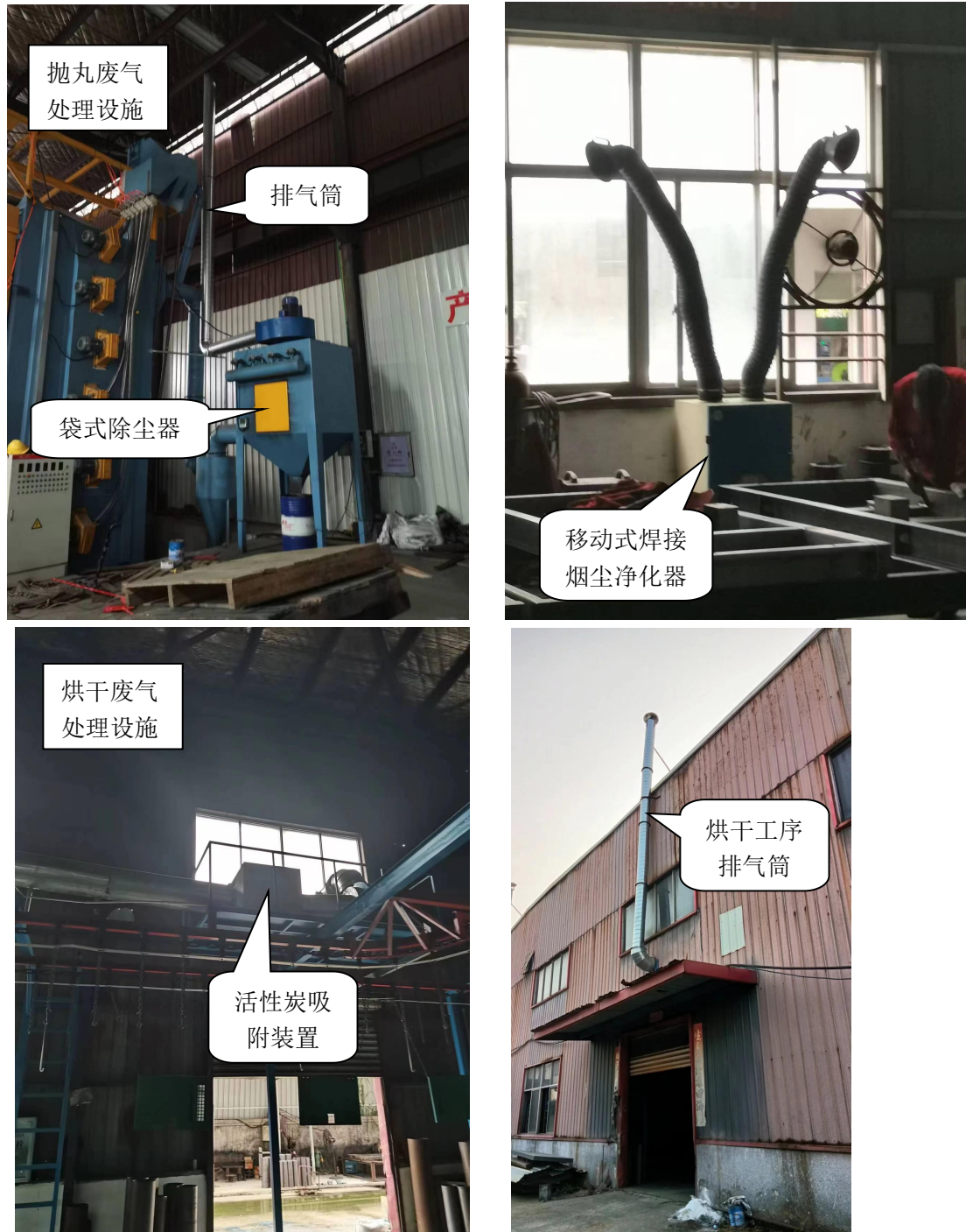
图 4-2 废气处理设施图
