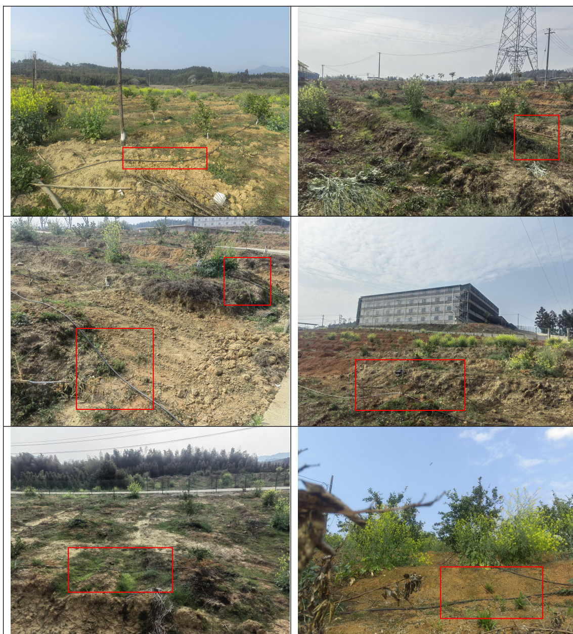
图4.1-4浇灌区及滴灌管线现场照片
