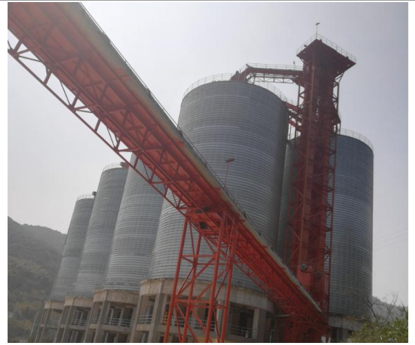
密闭空气斜槽及水泥筒仓
