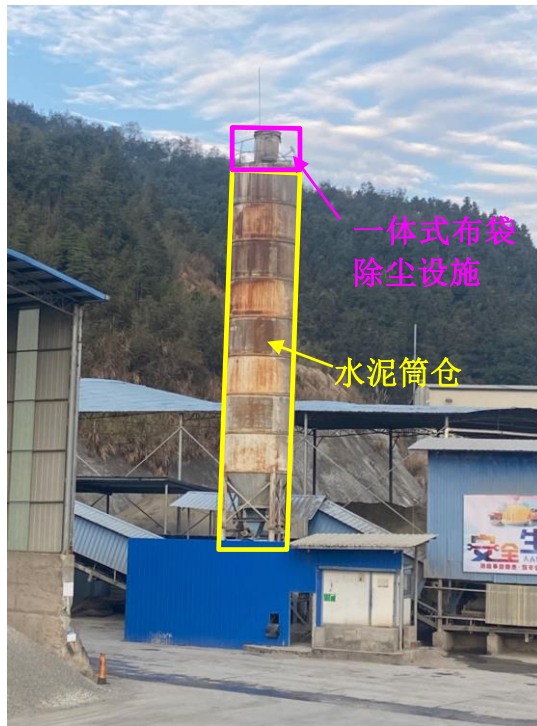
水泥筒仓及一体式布袋除尘设施
