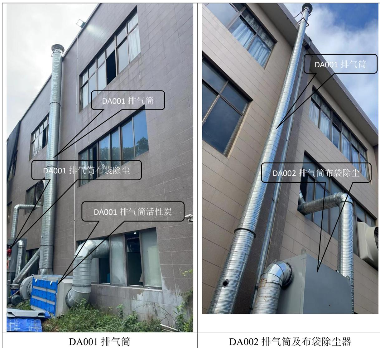
图4.1-2 废气处理设施相关图
