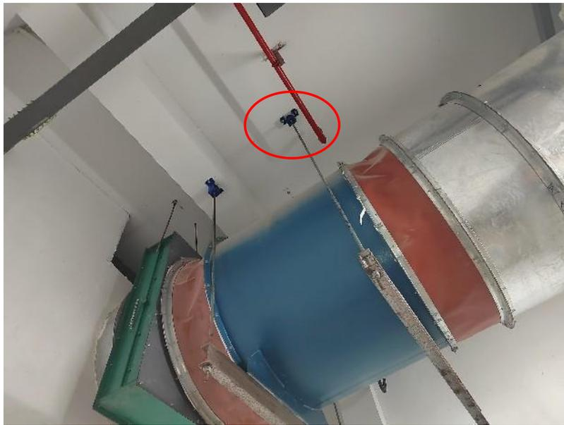
地下室送风系统风机设置减振弹簧
