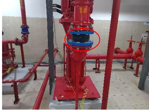
地下室消防泵房设置减振垫
