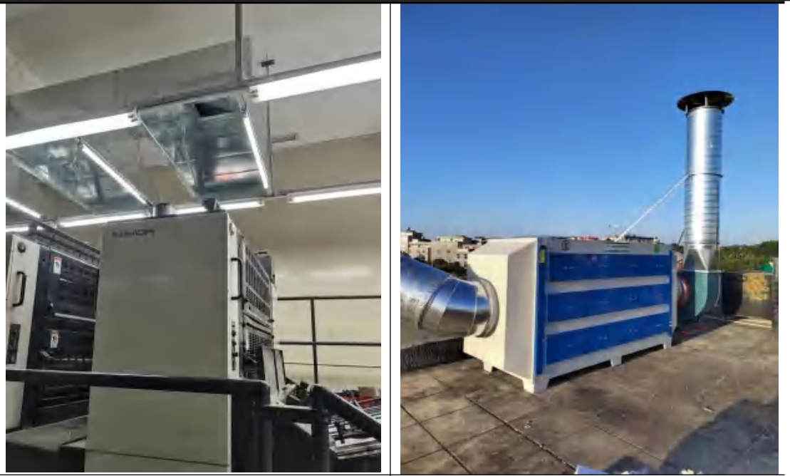
印刷工序集气罩
