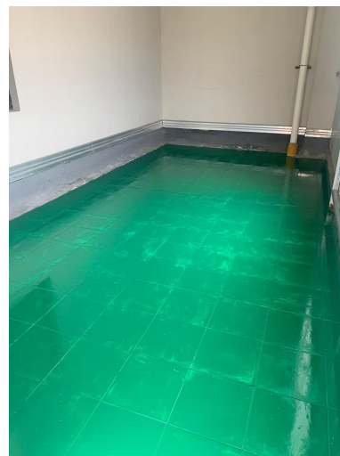
危废暂存间内部
