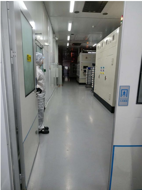
CT 机西侧过道（车间内）
