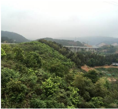
项目西侧-丘陵及高速公路
