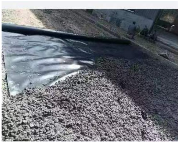
厂区铺设防渗膜
