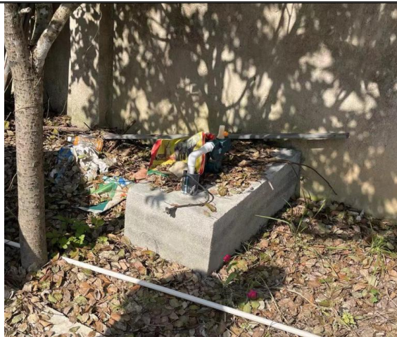
地下水监控井
