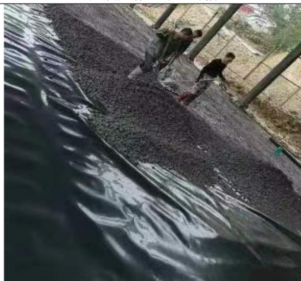
拆解车间铺设防渗膜
